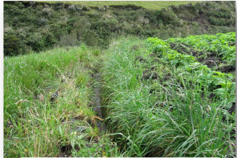
Zanjas de desviación de agua
